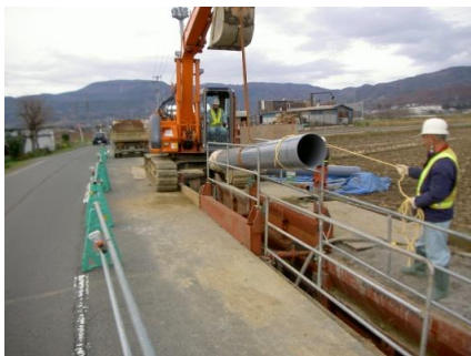
塩化ビニール管布設状況
