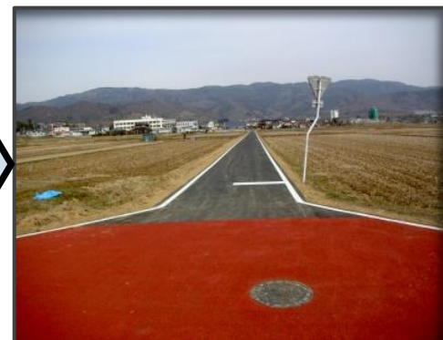
工事完了(H24.3)
