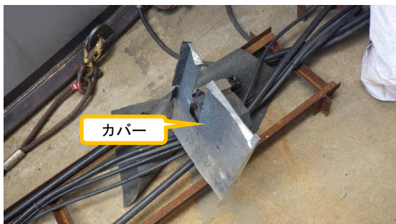
(写真3-1) 火種飛散防止用カバール
