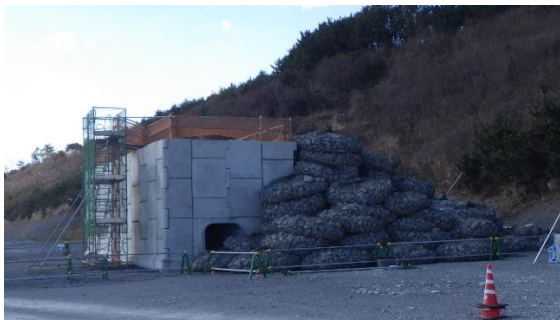
(写真1-1) 日本海溝津波防潮堤の試験施工体の 状況① (北東側から撮影)
