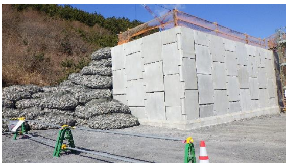
(写真1-2) 日本海溝津波防潮堤の試験施工体の 状況② (南東側から撮影)
