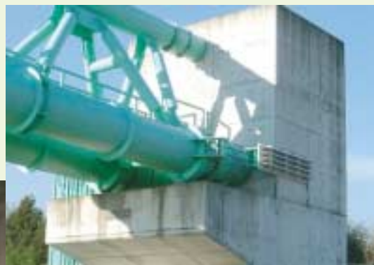
落橋防止装置 (松川水管橋)
