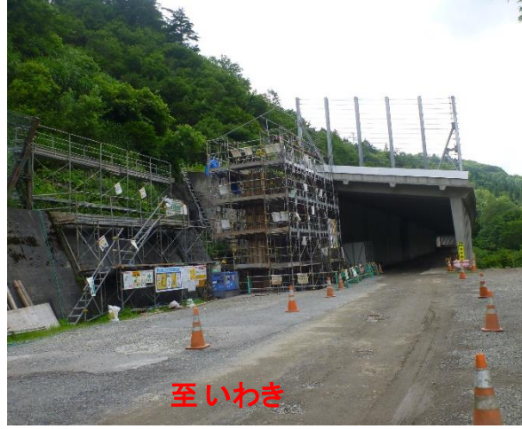
スノーシェッド工事状況
