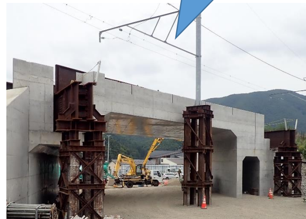
南会津町田島地内
