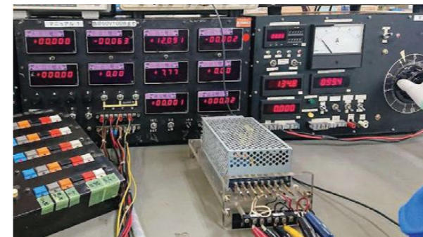
電源検査シーン
