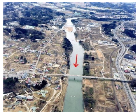
水防災対策特定河川事業 阿武隈川（二本松・安達地区）
