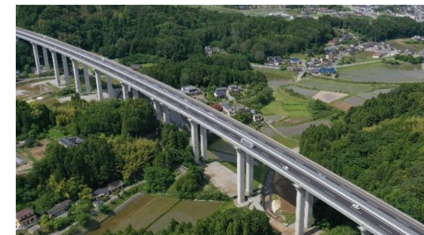
常磐自動車道(いわき中央IC～広野IC) 令和3年6月13日 4車線運用開始
