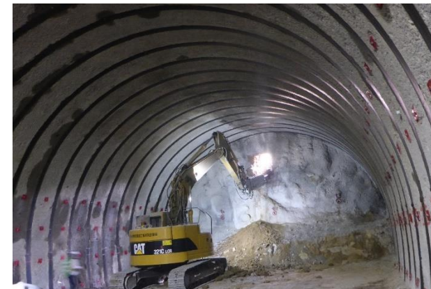
国道114号 川俣町工区関場トンネル 令和4年3月2日 貫通
