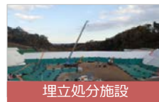
埋立処分施設
