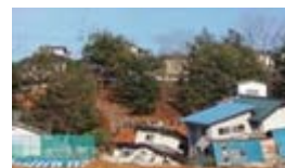
家屋被害：福島市
