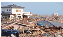
津波被害：浪江町
