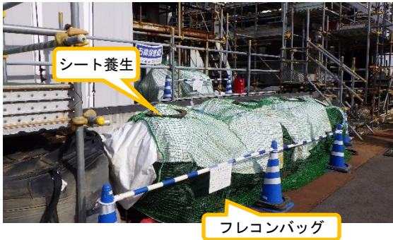
(写真3-1) 被覆材の仮置き状況 (令和3年11月29日撮影)
