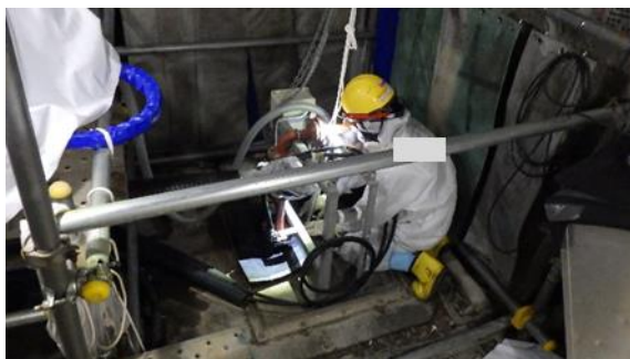
(写真 3-1) サブドレンピットNo. 40の確認作業 の状況
