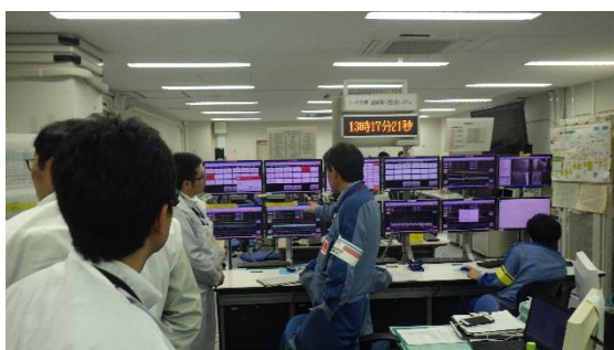
（写真1－1） 免震重要棟集中監視室
