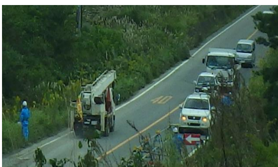
(写真 1 - 2) 片側通行の状況
