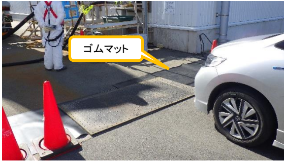
(写真3) 排水溝の養生の状況
