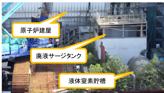
(図2) 1号機原子炉建屋西側詳細図
