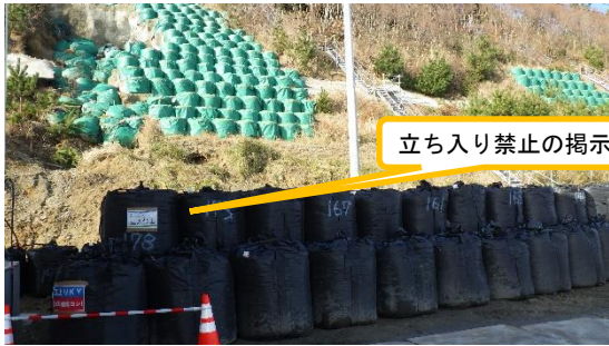
(写真3) 大型土嚢設置状況 (東側から令和2年1月10日撮影)
