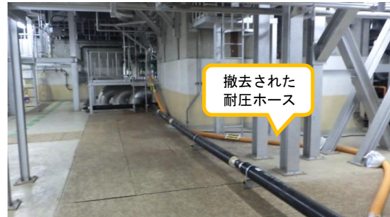
(写真 1 - 4) 前回 (令和元年 9 月 30 日) 撮影
