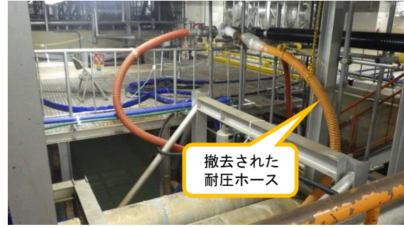
(写真 1 - 2) 前回 (令和元年 9 月 30 日) 撮影
