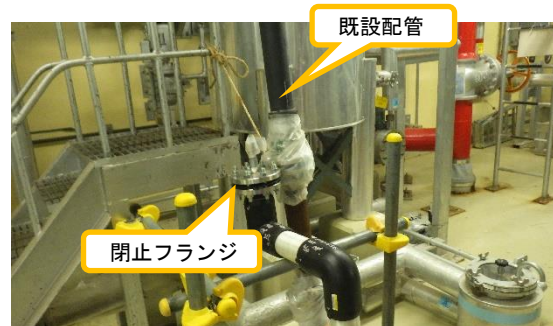
(写真 2 - 2) 前回 (令和元年 9 月 30 日) 撮影
