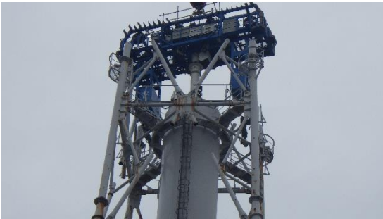
(写真3) 排気筒頂部の状況 10時30分頃撮影
