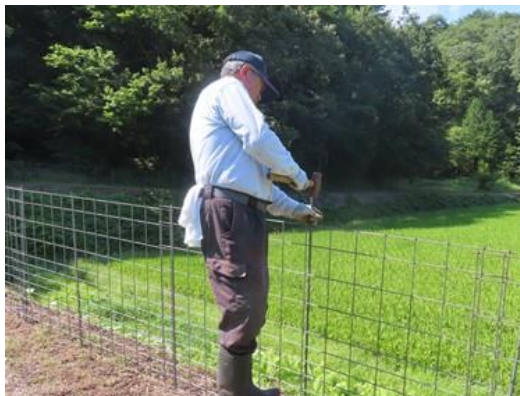
図2 設置の様子(土台があると杭の打ち込みが容易になる)
