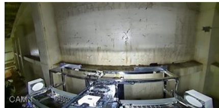
高所壁面除染後
