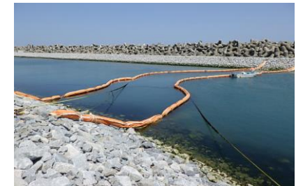
(既設)5・6号機取水路開渠シルトフェンス展張状況
