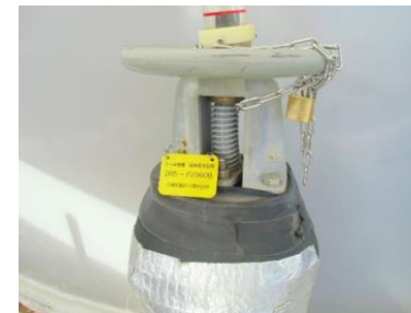
J3雨水回収タンク払出弁
