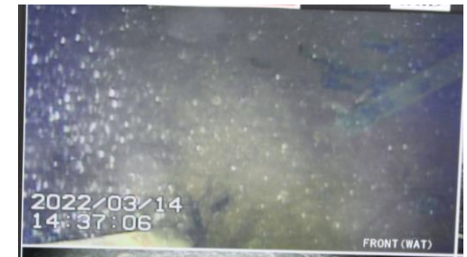
原子炉格納容器底部水面への着水時の状況
