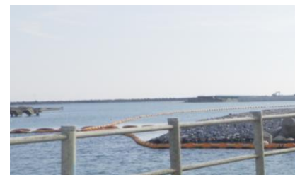
(既設)重油オイルフェンス展張状況
