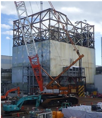
1号機原子炉建屋現場状況
