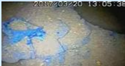
ペDESTAL外側の状況
