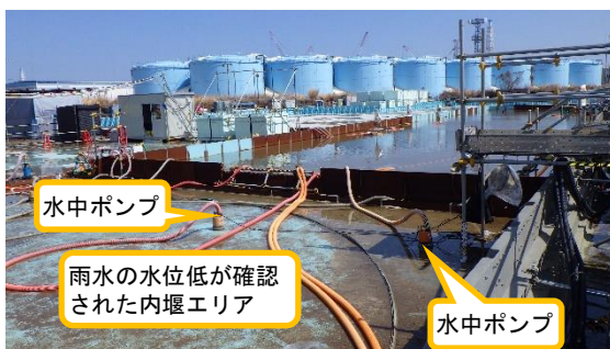
(写真2-2) 雨水の水位低下が確認された内堰エ リアの雨水移送状況 (南西側から撮影)
