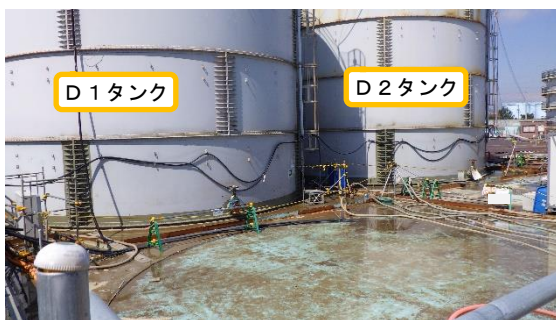
(写真2-1) 雨水の水位低下が確認された内堰エ リアの状況 (南東側から撮影)
