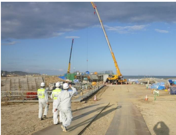
※安全パトロールの状況
