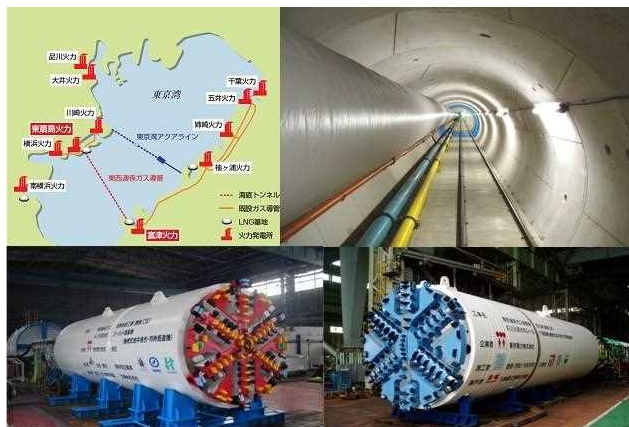
シールド工法 (東京電力株式会社 2009年 東京湾横断部 東西連携ガス導管トンネル : 約18 km)
