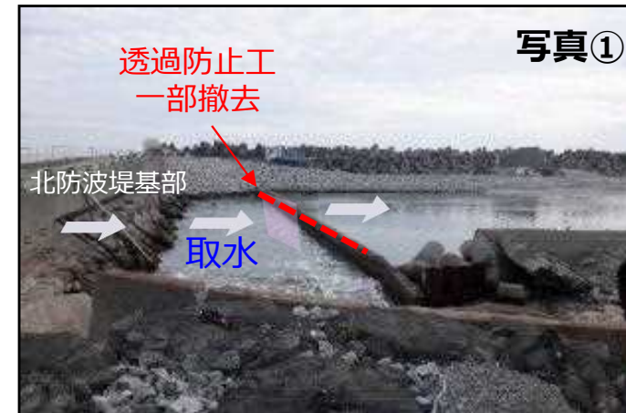
透過防止工撤去イメージ図
