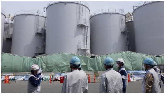
(写真2) K4タンクエリアの確認状況
