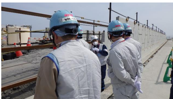
(写真5) 日本海溝津波防潮堤の確認状況
