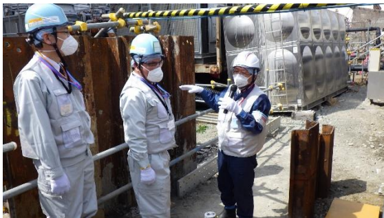
(写真4) 鋼矢板と陸側遮水壁設備の確認状況
