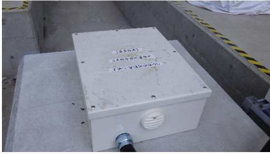
(写真2) 地震計の設置状況③ (西側から撮影)
