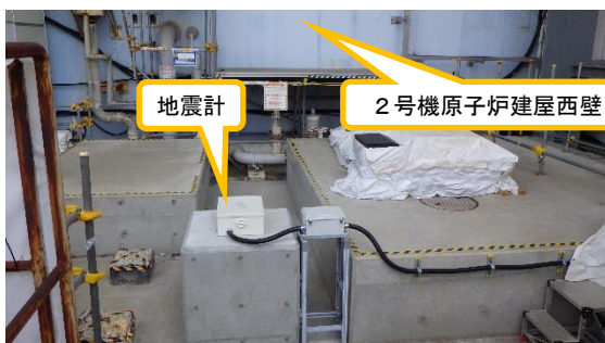
(写真1-1) 地震計の設置状況① (西側から撮影)
