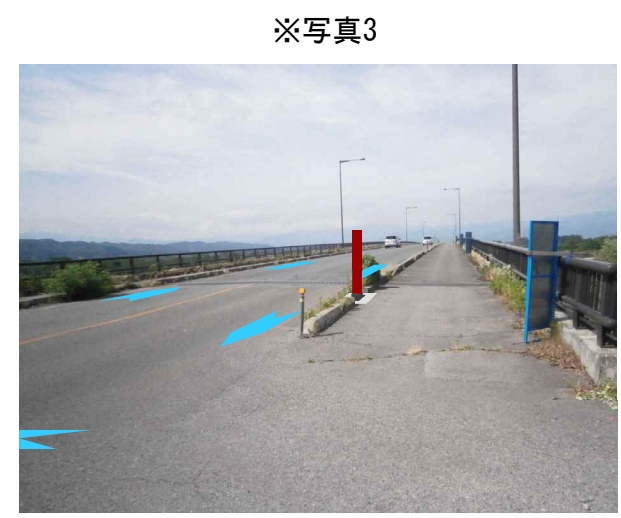
⑤ - 2 未整備暫定区間(塩川工区会青橋)
