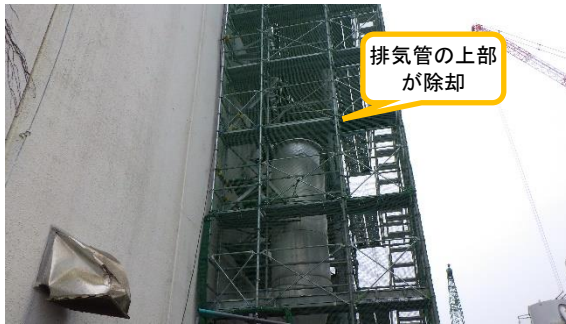
(写真 2 - 1) 3, 4号機建屋周辺の排気管の状況 (令和4年2月10日撮影)
