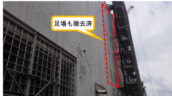
(写真 2 - 2) 今回の状況 (令和4年4月18日撮影)
