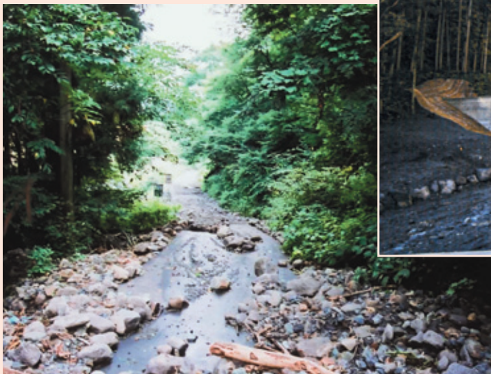
豪雨により荒廃溪流から土砂が流出
