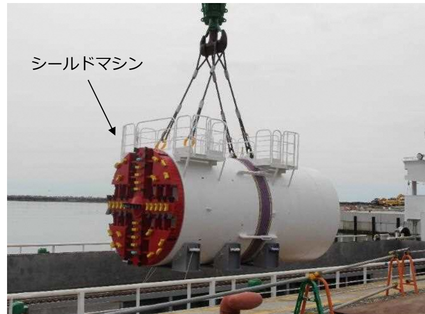
シールドマシン陸揚げの状況
