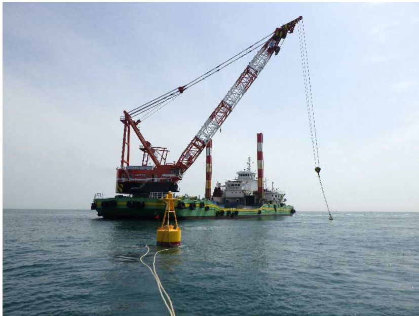
灯浮標の設置状況
