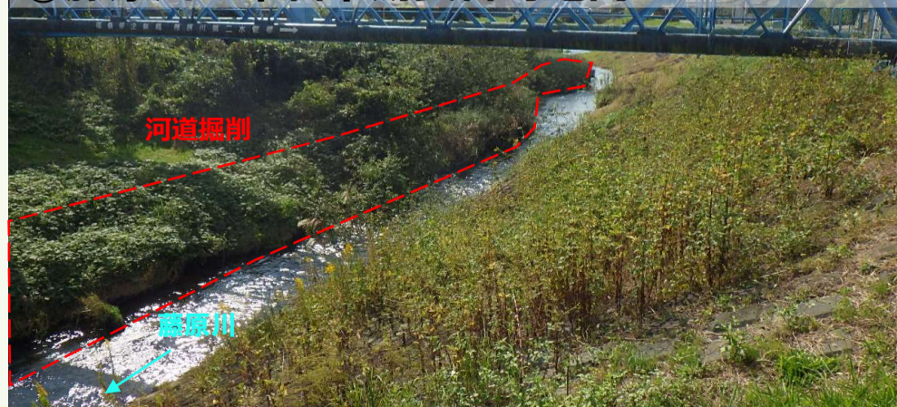
②藤原川 常磐下湯長谷町地内 【施工前】
