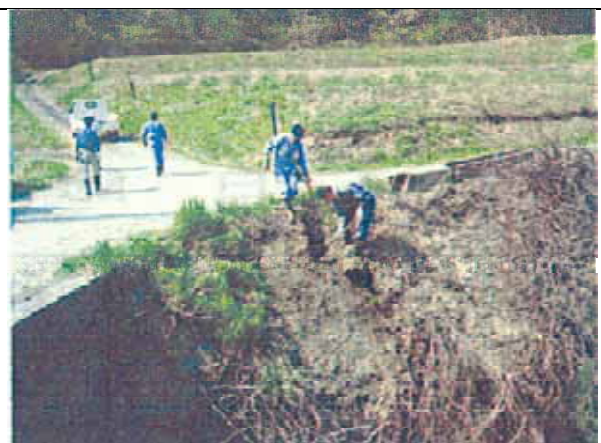
災害復旧工事の様子
