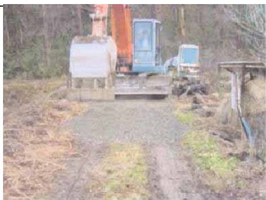
農道の簡易補修（砂利敷き）
