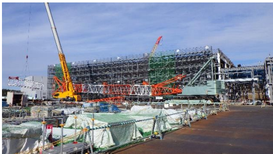
(写真1-1) 建屋の鉄骨組立の状況 (令和4年1月6日撮影)
