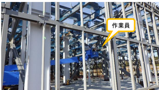
(写真1-3) ボルトの本締作業の状況 (令和4年1月6日撮影)
