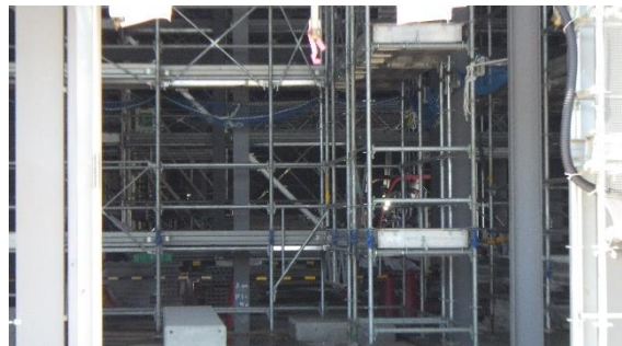
(写真1-4) 減容処理設備建屋建設工事の状況 (令和4年6月13日撮影)
