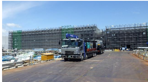
(写真1-2) 減容処理設備建屋建設工事の状況 (令和4年6月13日撮影)
