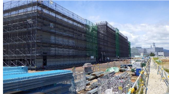
(写真1-6) 減容処理設備建屋建設工事の状況 (令和4年6月13日撮影)
