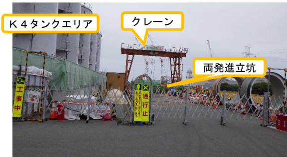
(写真1-1) 両発進立坑地上部の概観 (西側から撮影)
