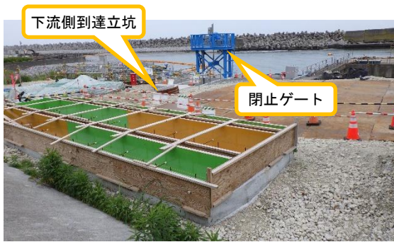
(写真3) 下流側到達立坑周辺の状況 (南西側から撮影)
