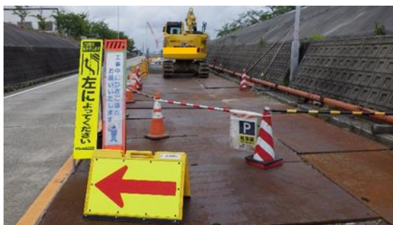
(写真2-2) 上流側到達立坑地上部の状況② (東側から撮影)
