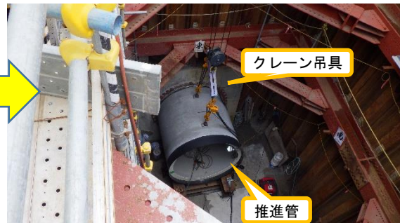
(写真1-3) 両発進立坑内部の下流側の状況② (今回(6月15日)北西側から撮影)
