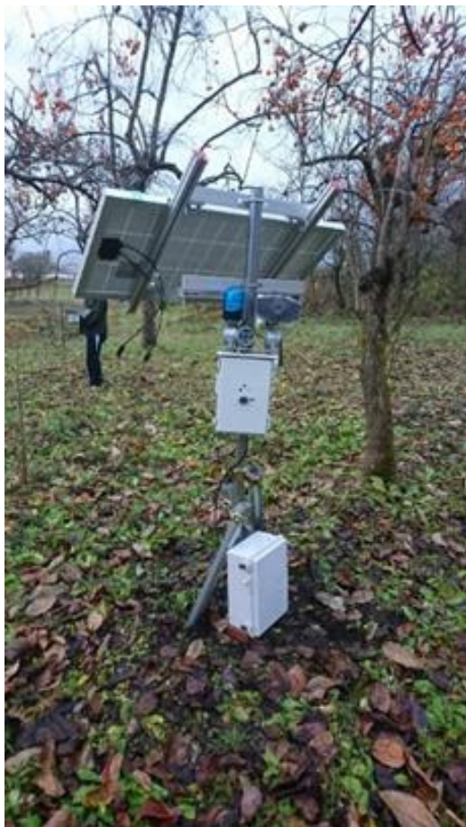
検出システムを搭載した警報装置
