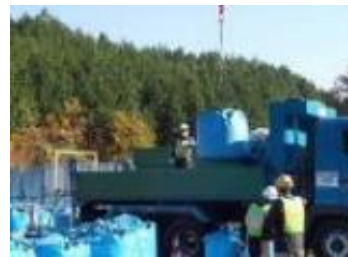
除去土壌等の車両積込状況
