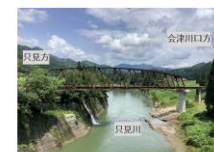
桁架設及び軌道工事完成
