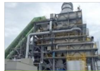
仮設焼却施設
