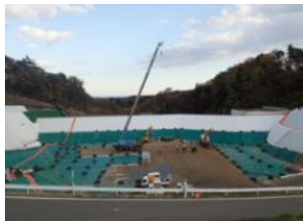
埋立処分施設の状況
