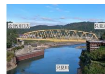
桁架設及び軌道工事完成
