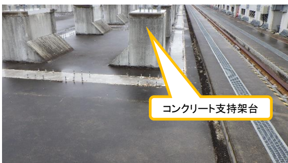
(写真3) コンクリート支持架台の設置状況
