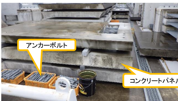
(写真2) コンクリートパネル等の資材の保管 状況
