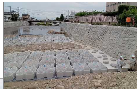
根固ブロック 設置状況
