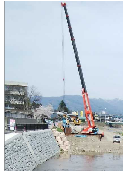
仮設矢板打ち込み状況
