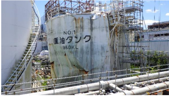
(写真1) No. 1 重油タンクの状況 (北東側から撮影)
