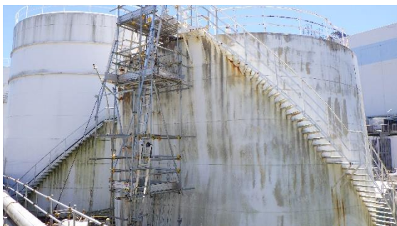
(写真3) 仮設足場の状況
