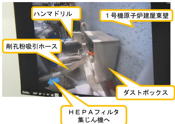
(写真2) アンカー削孔作業の状況①
