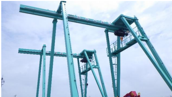
(写真 1) 新たに設置された橋形クレーン 2 台
