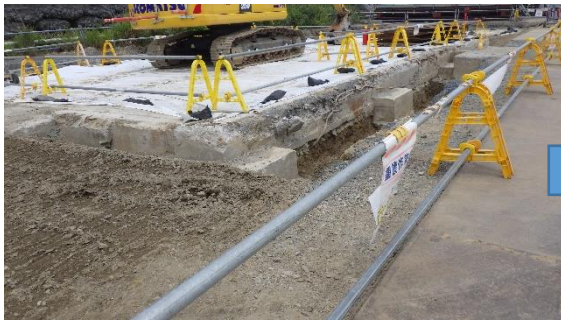
(写真3-1) 試掘の状況 (令和4年6月17日撮影) (南東側から撮影)
