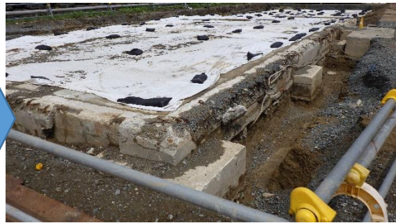
(写真3-2) 試掘の状況 (令和4年7月15日撮影) (南東側から撮影)
