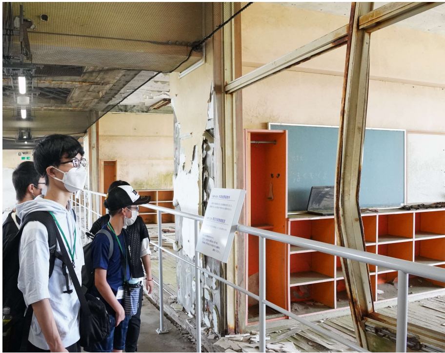
津波に襲われた教室。残された鉄骨が曲がっている
