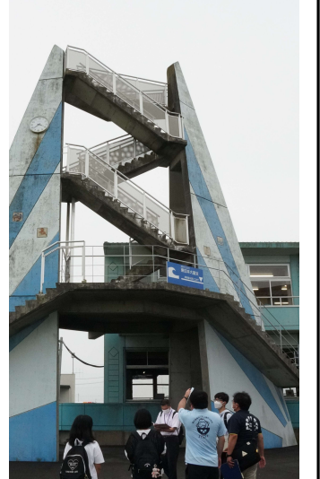
請戸小のシンボルの一つであるヨットの帆の形をした展望台。中央部には津波到達地点のプレートがある
