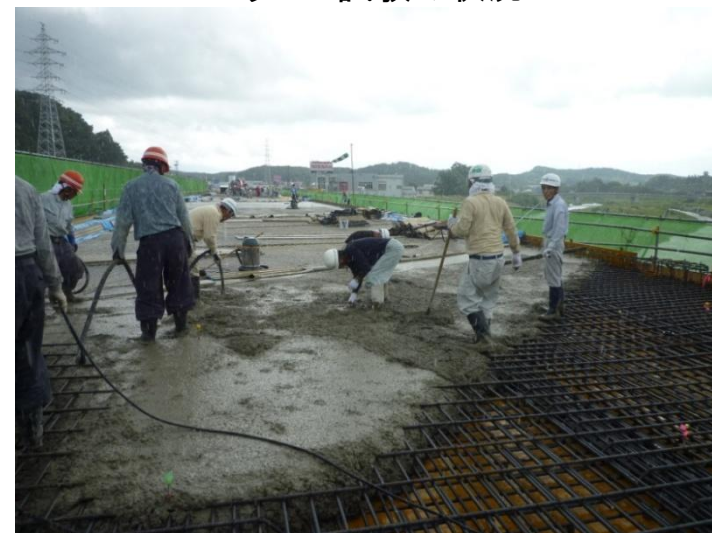
コンクリート打設の状況
