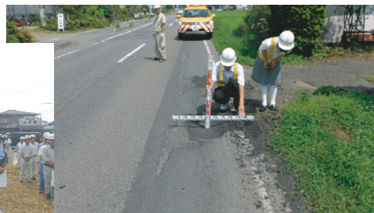
民間パトロール 路面の段差確認
