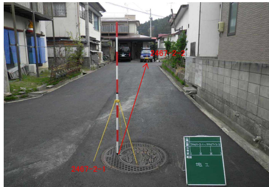
写真3-2 会津若松市 復旧状況
