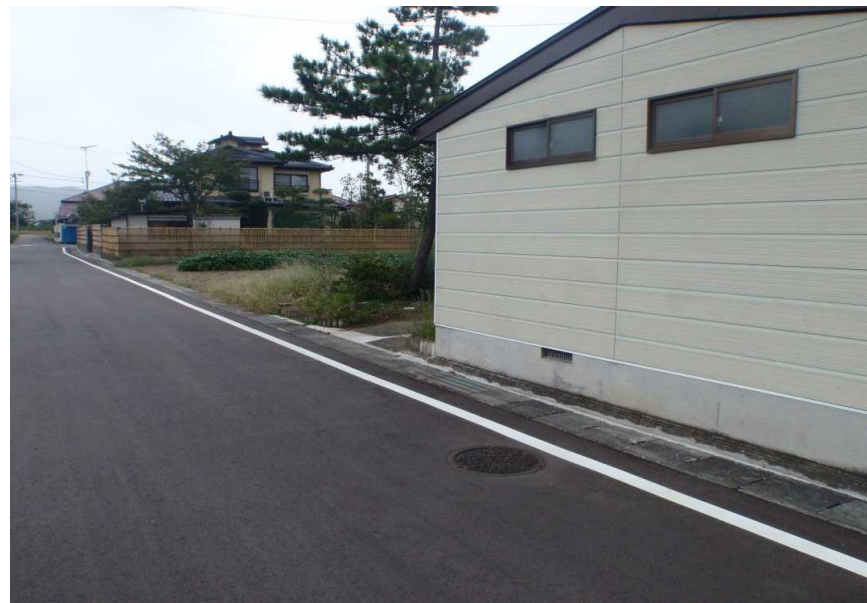
写真6-2 国見町 復旧状況
