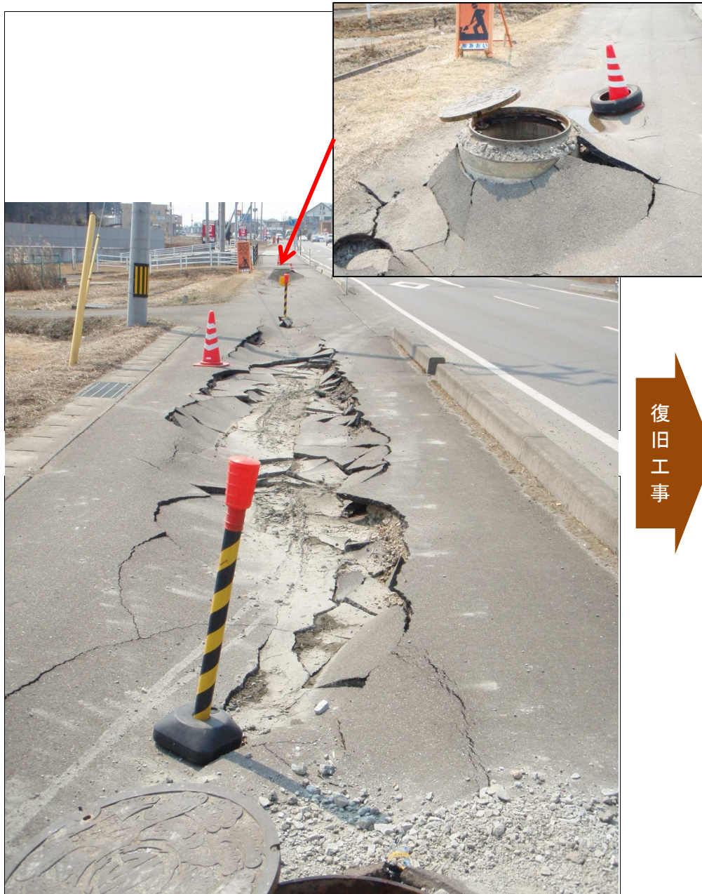
写真9-1 矢吹町 管路損傷に伴う道路の陥没及びマンホール浮上
