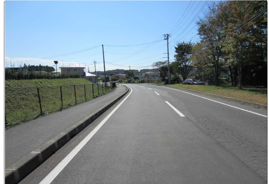
写真1-2 西郷村 復旧状況
