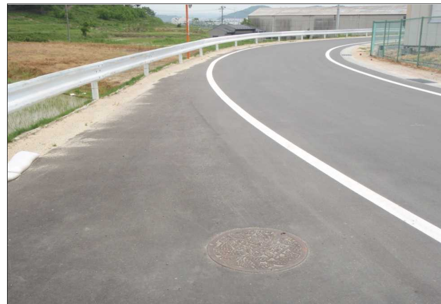
写真4-2 本宮市 復旧状況
