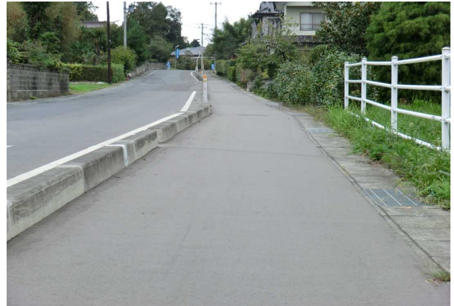
写真7-2 新地町 復旧状況
