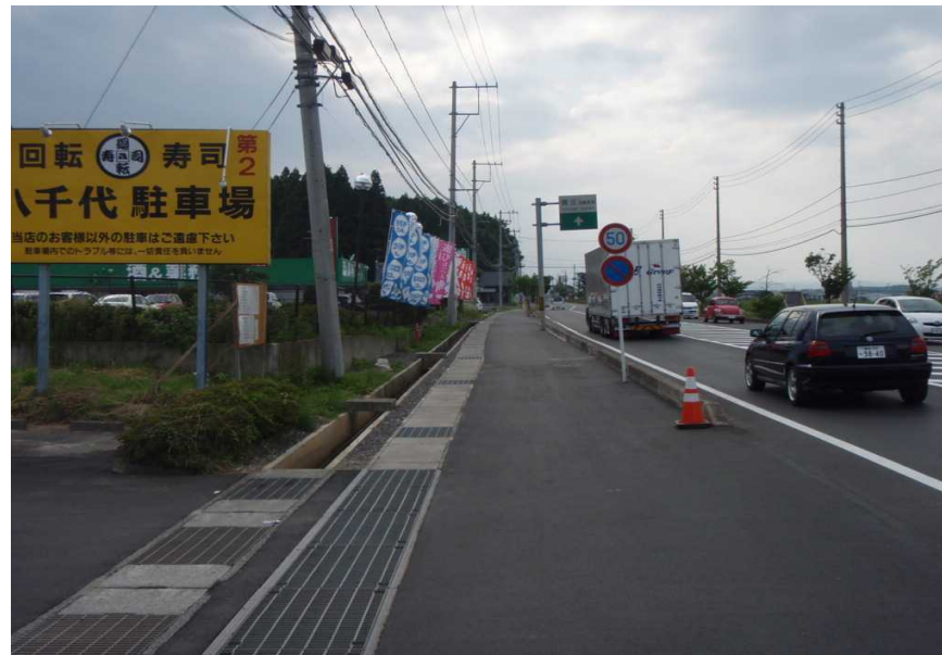
写真5-2 白河市 復旧状況
