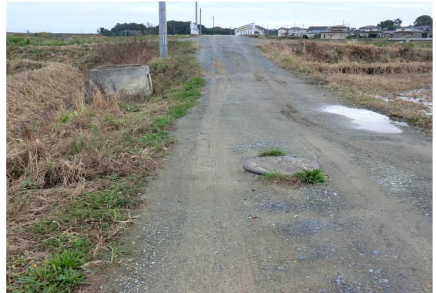
写真8-2 新地町 復旧状況
