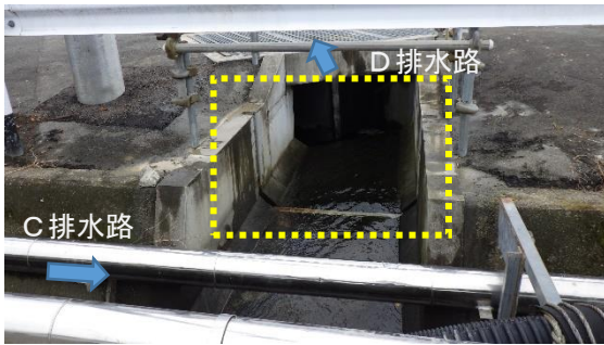
(写真3-1) D排水路運用開始後におけるC排水路とD排水路接続部（黄枠内）
