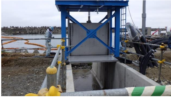
(写真2) 排水路出口ゲート開放の状況
