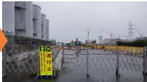
(写真4-2) 両発進立坑跡地（西側から撮影） （撮影日：令和4年8月30日）
