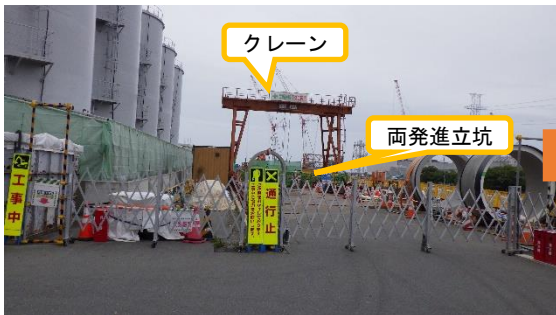
(写真4-1) 両発進立坑地上部（西側から撮影） （撮影日：令和4年6月15日）
