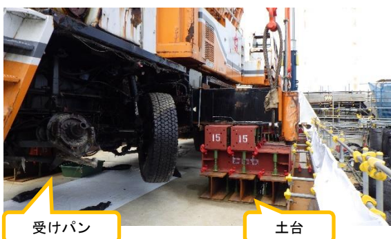
(写真5-3) クレーン土台の状況
