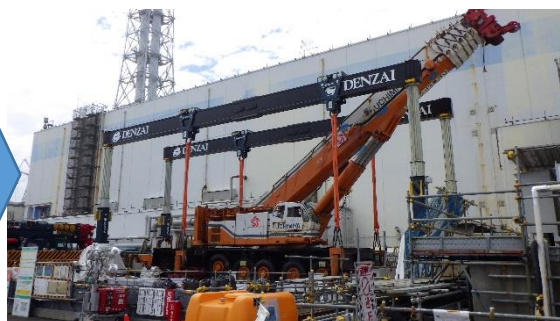
(写真5-2) 移動後のクレーンの状況 写真奥側に移動されている。(撮影 日:令和4年9月2日)
