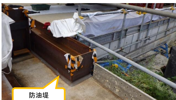
(写真6) 防油堤の状況
