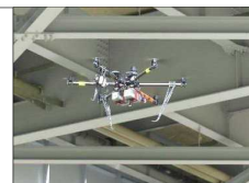
ドローンによる橋梁点検
