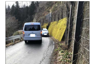
車両のすれ違いが困難な箇所 (会津若松三島線 三島町)
