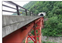
耐震補強を実施する橋梁 (国道121号 喜多方市)
