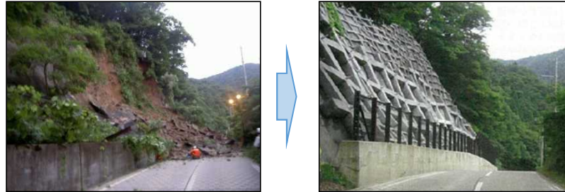
法面对策（法枠工）を実施した道路 （湯川大町線 会津若松市）
