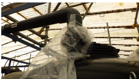
(写真3-2) ウルトラフィルタ洗浄水槽の養生された箇所の例① (タンク上部)
