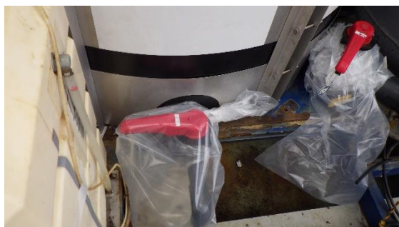
(写真3-3) ウルトラフィルタ洗浄水槽の養生された箇所の例② (タンク下部)
