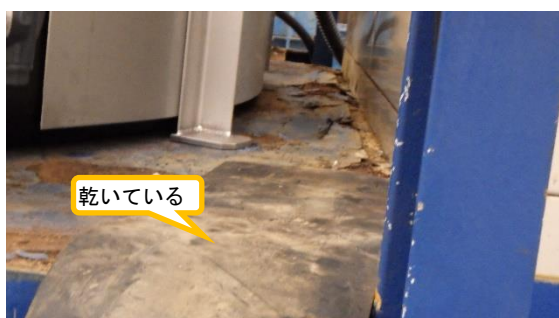
(写真4) ウルトラフィルタ洗浄水槽下部の状況
