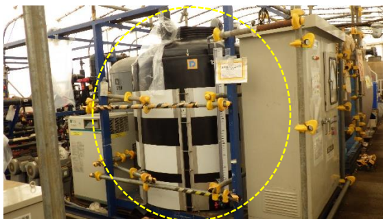
(写真3-1) ウルトラフィルタ洗浄水槽の外観
