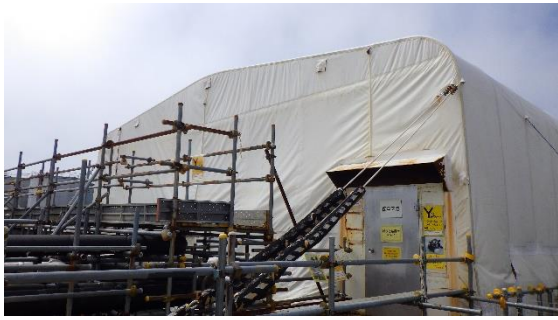
(写真1) RO-3 ジャバラハウス周辺の状況
