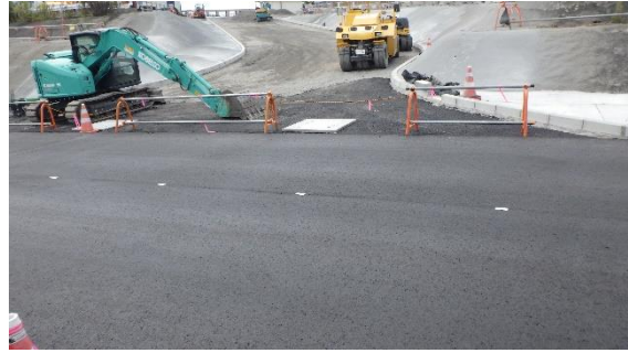
(写真1-2) 汐見坂から見た工事の状況（北西側より撮影）（今回撮影）
