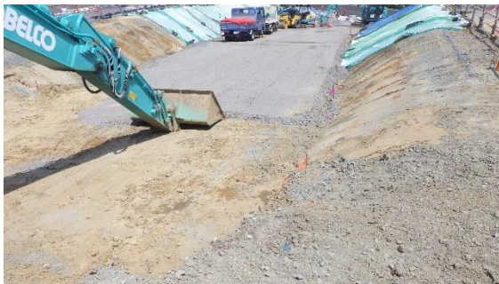
(写真3) 工事の状況（南側より撮影）（前回撮影）
