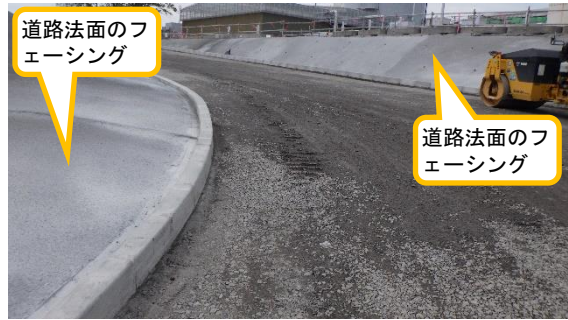
(写真2-2) 工事の状況（北東側より撮影）（今回撮影）
