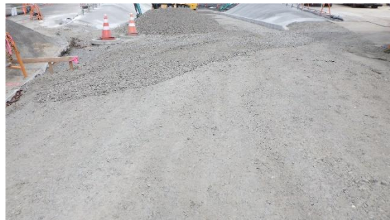
(写真3) 工事の状況（南側より撮影）（今回撮影）
