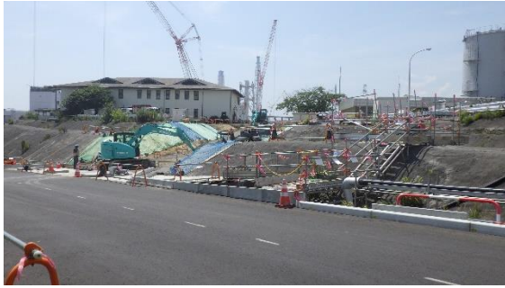
(写真1-1) 汐見坂から見た工事の状況（北西側より撮影）（前回撮影）
