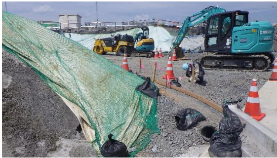
(写真2-1) 工事の状況（北東側より撮影）（前回撮影）
