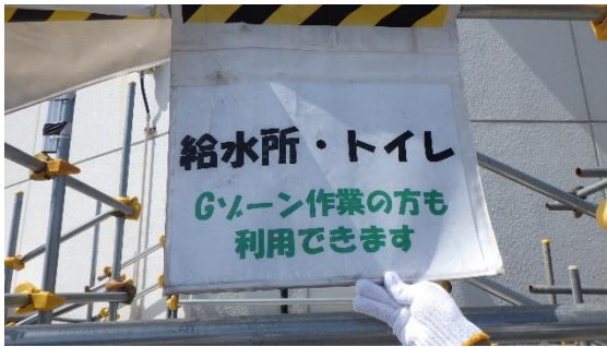
(写真6-1) 1, 2号サービス建屋に設置されている給水所の表示
