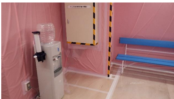
(写真6-3) 1, 2号サービス建屋に設置されている給水所の内部① ウォーターサーバーが設置されている。
