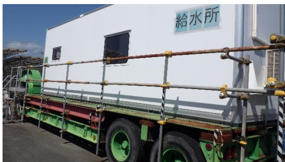
(写真 4 - 1) B タンクエリア西側に設置されている給水所
