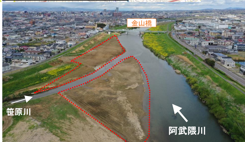
掘削後 (R4.4月撮影)
